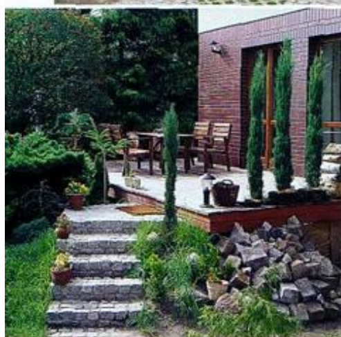
↑ Dom był podpiwniczony, z podłogą parteru mniej więcej 80 cm ponad terenem. Duży drewniany taras obsypany gruntem i obrośnięty zielenią połączył dom z ogrodem
