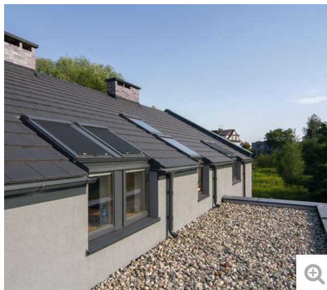
Żwir na dachu parterowych przybudówek pełni funkcję ozdobną, dociska położone na stropie płyty XPS i chroni je przed promieniowaniem UV fot. Piotr Mastalerz
